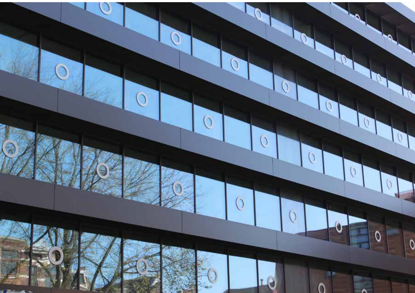
De gevelbanden geven De Walvis zijn unieke identiteit.
